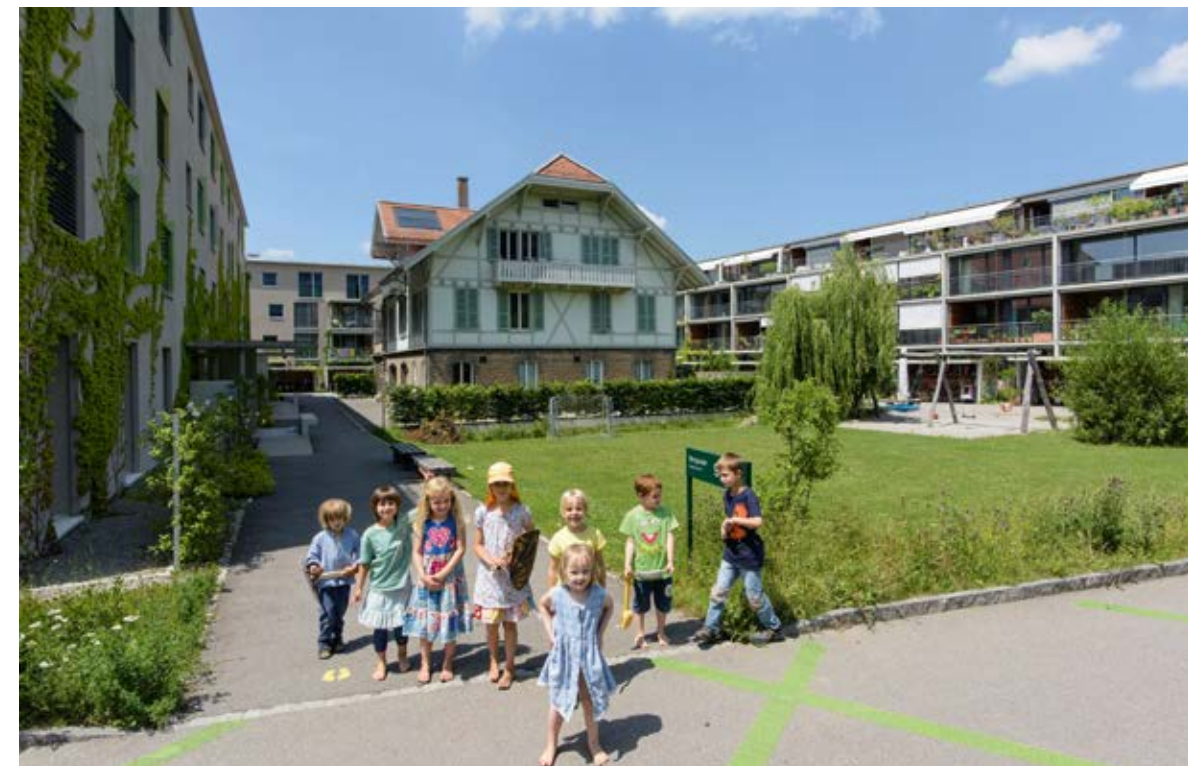
In Bümpliz (BE) steht seit fünf Jahren die autofreie «Siedlung Burgunder». In deren Mitte wurde ein denkmalgeschütztes Gebäude energetisch saniert und dient nun als Kita und Gemeinschaftsraum. www.npg-ag.ch
